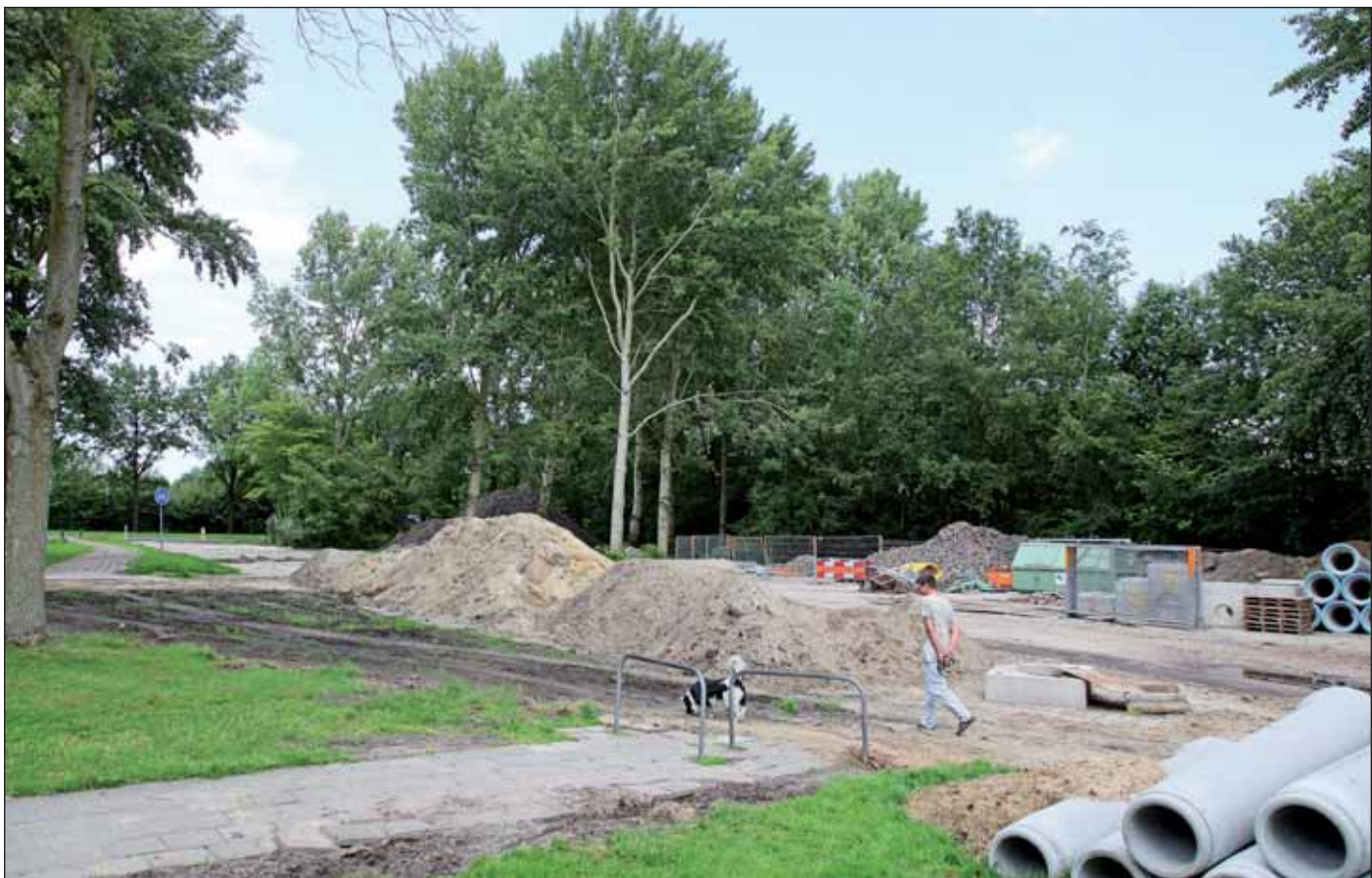
Op de foto zijn de werkzaamheden nog in volle gang, maar inmiddels is de nieuwe laan helemaal klaar. Achter de bomen ligt het voormalige rugbyterrein.
